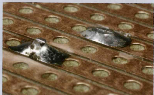
Die vordere Lötstelle ist optimal während bei der rechten das Ende des Beins zu tief (durch den Kegel) abgeschnitten wurde.
